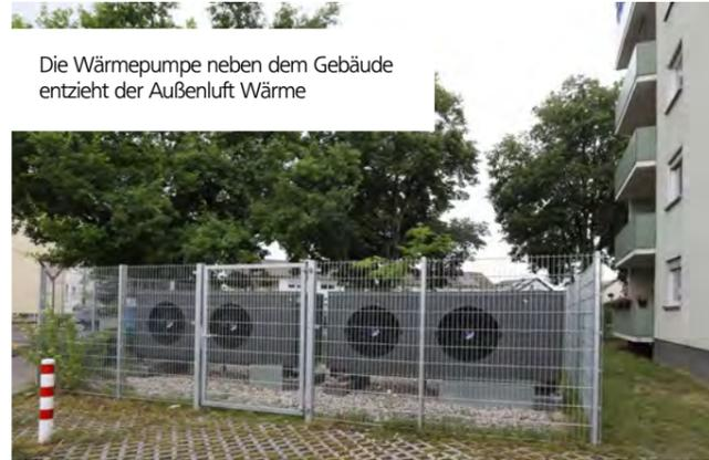
Die Wärmepumpe neben dem Gebäude entzieht der Außenluft Wärme
