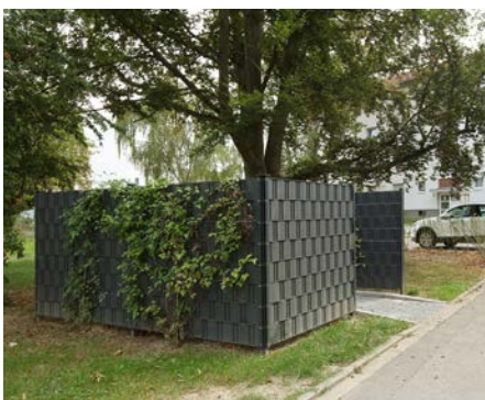
Der Sammelplatz – hier im Hermann-Löns-Weg – fügt sich gut in die Umgebung ein
